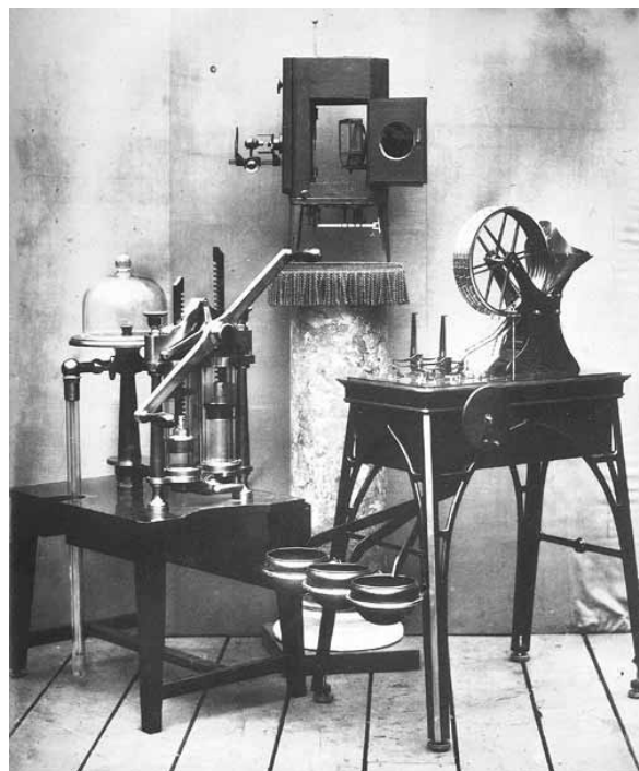
fig. 4 - Trois instruments exposés à Londres par le constructeur français Deleuil. De gauche à droite : une pompe pneumatique, un microscope de projection avec lampe à arc et la balance monétaire automatique du Baron Séguier. (Tiré de : Patrick Beaver, The Crystal Palace, London, H. Evelyn, 1970)
